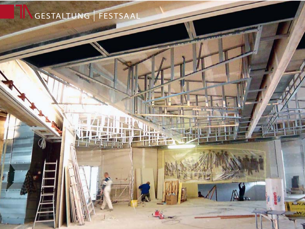
Ausbauphase des Foyers. Die Unterkonstruktion für die Lichtdecke im Foyer besteht aus 60/27-Profilen, ist aber teilweise mit Weitspanträgern abgefangen.
