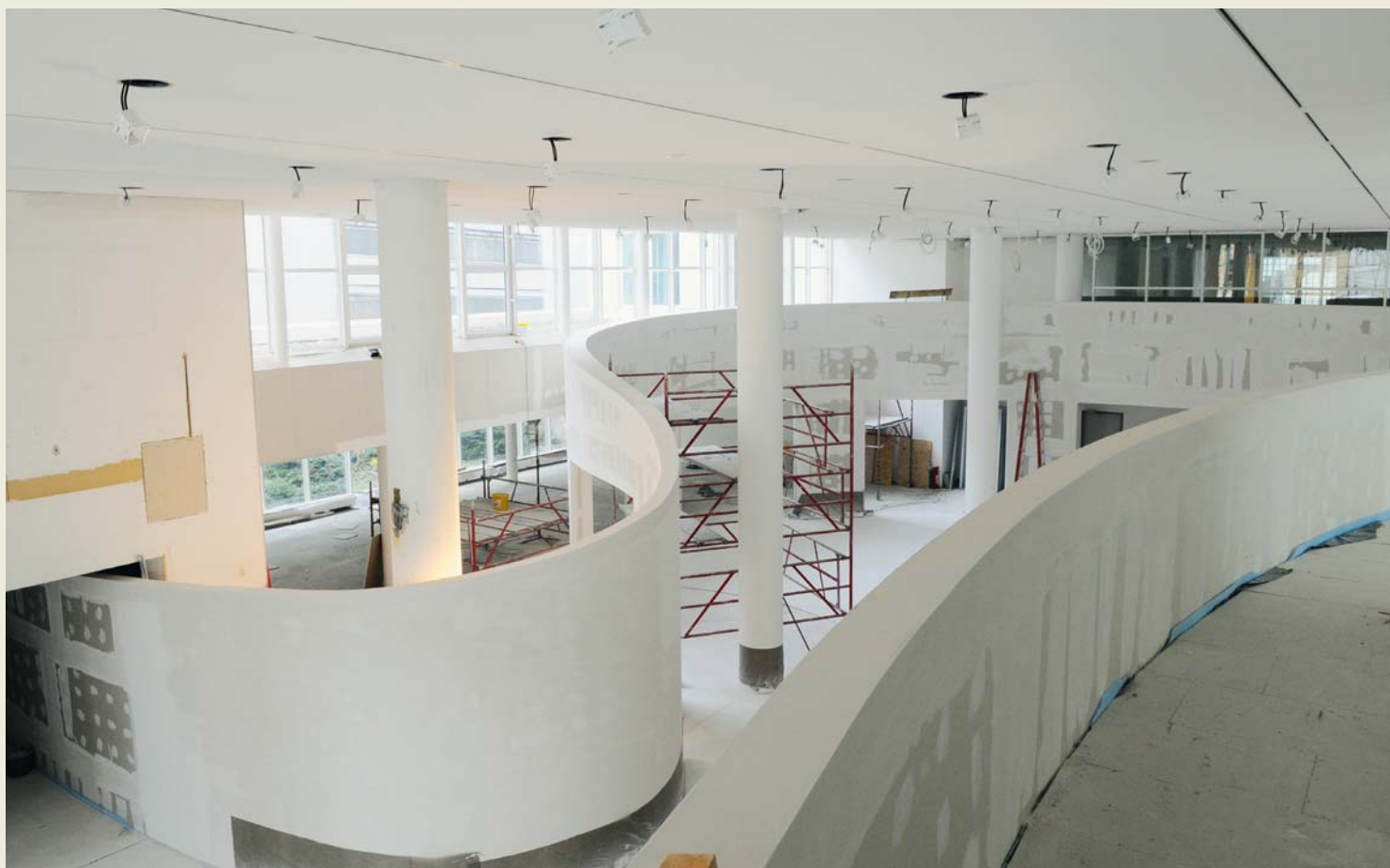
Freie Form. Wie eine abgelegte Perlenkette schwingt die Raumtrennwand durch die gesamte ehemalige Schalterhalle der Aktienbank. Das vordere Profil und die vordere Beplankung laufen durch, die hinteren Profile stehen auf der Zwischendecke bzw. sind von unten an der Zwischendecke befestigt.
