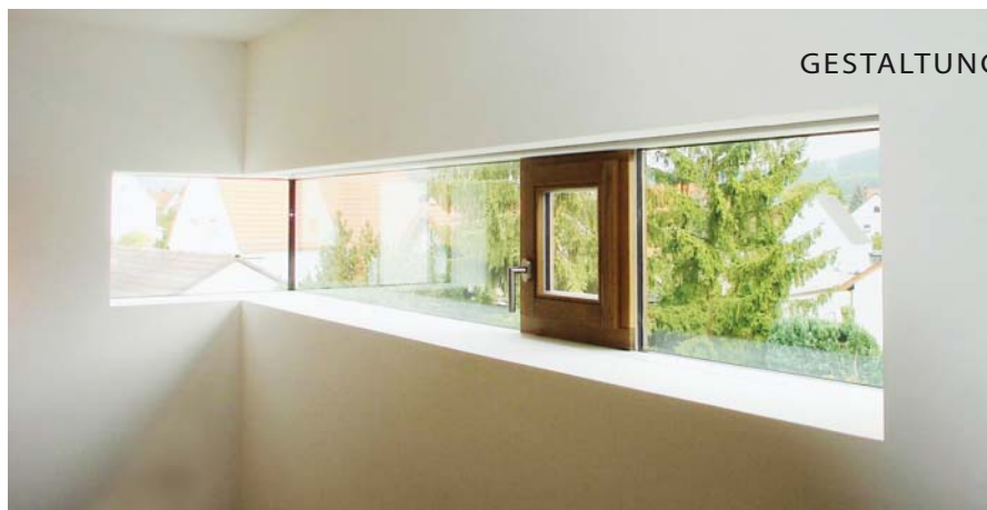
Mit Vorsatz. Der Innenausbau des Einfamilienhauses erfolgte mit Vorsatzschalen und doppelt beplankten Ständerwänden.
