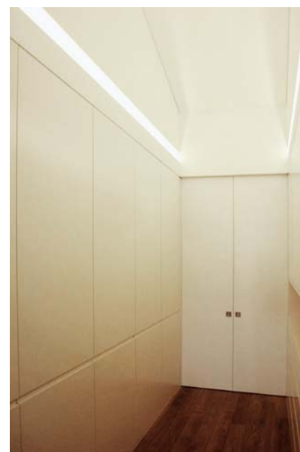
Hängeschrank. Im Ankleidezimmer kamen von oben freihängende Vorsatzschalen zum Einsatz. Bündige Türen und umlaufende Schattenfugen runden das Design ab.
