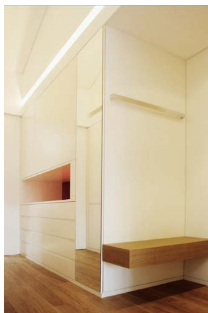
Gebautes Mobiliar. Wandeinbauten, Vorsatzschalen, Lichtvouten und indirekte Beleuchtung wurden in Trockenbauweise nach den Vorgaben des Architekten umgesetzt.
