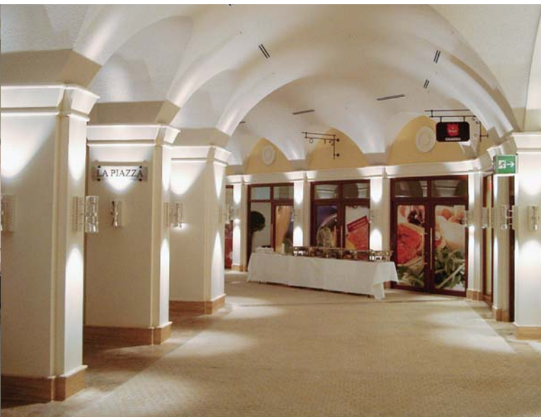
Den Bogen raus. Handwerkliches Können bewies das Ausbaunternehmen auch mit der Ausführung der Gewölbedecken in Shoppingmall und Arkaden.
