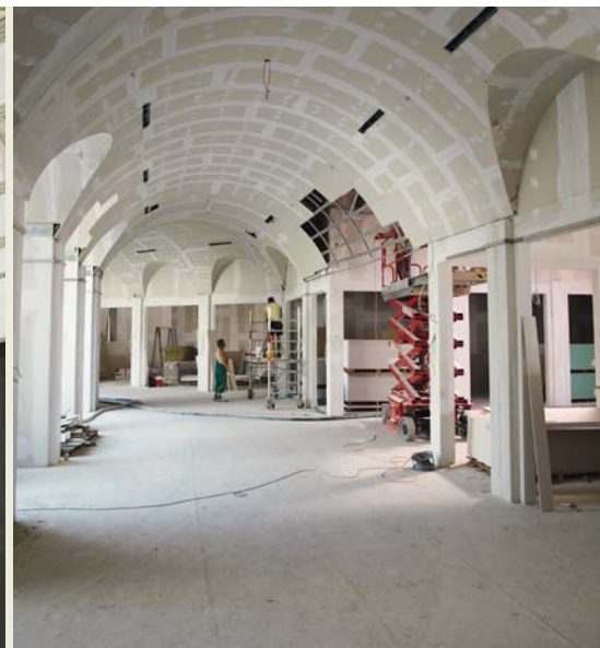
Arkadia. Die Gewölbedecke der Arkaden wurde doppelt mit 12,5 mm dicken Bauplatten beplankt und anschließend mit einem Akustikputz beschichtet.
