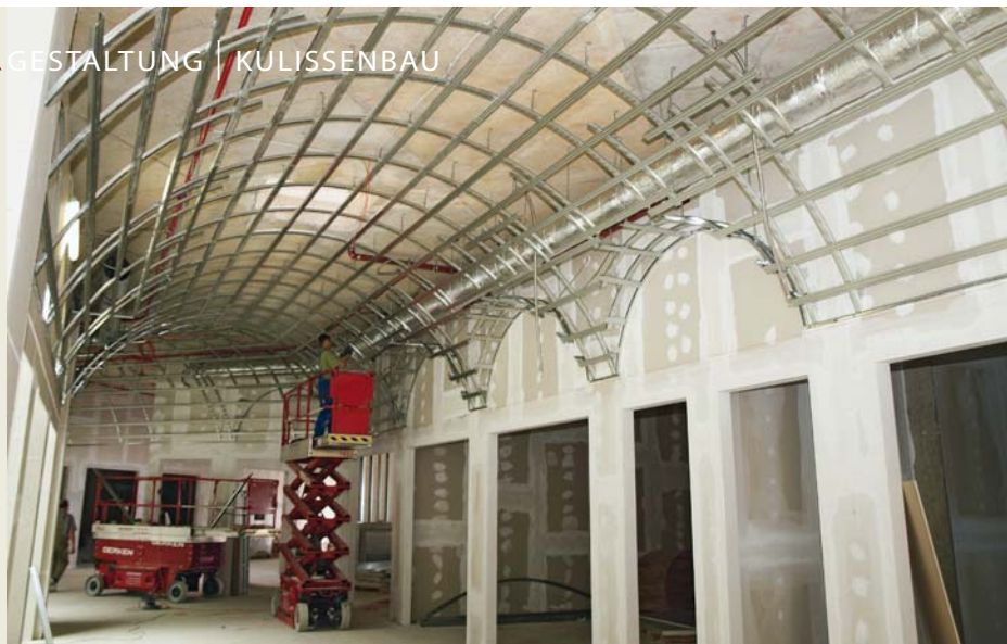
Arkaden-Gewölbe. Die Unterkonstruktion für die zwei- bzw. dreidimensional gewölbten Decken wurde aus gebogenen CD-Profilen erstellt.
