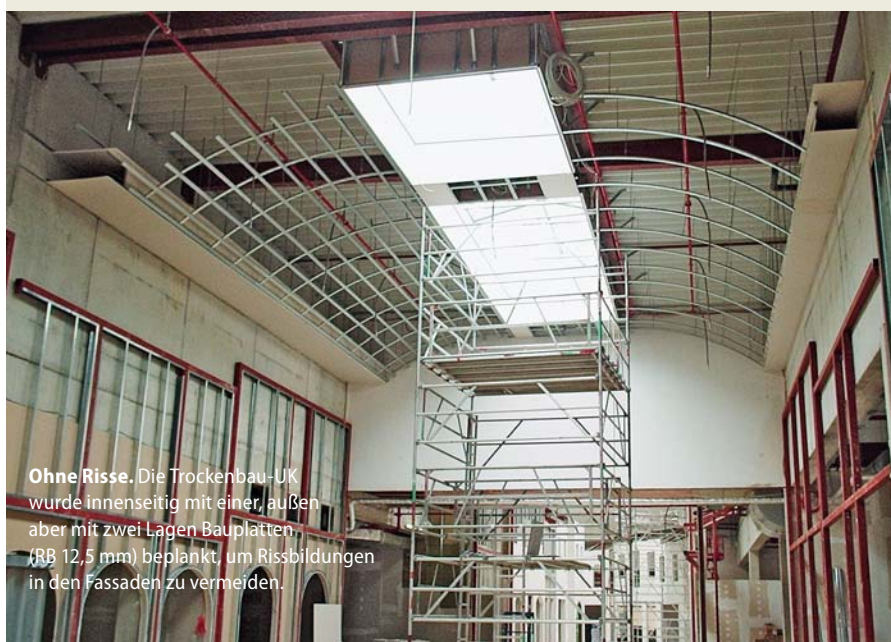
Handarbeit. Jede einzelne Fassade der Ladenlokale wurde individuell erstellt. Vormontierte Stahlkonstruktionen an den Rohwänden dienten als Basis für die Trockenbau-Unterkonstruktionen.
