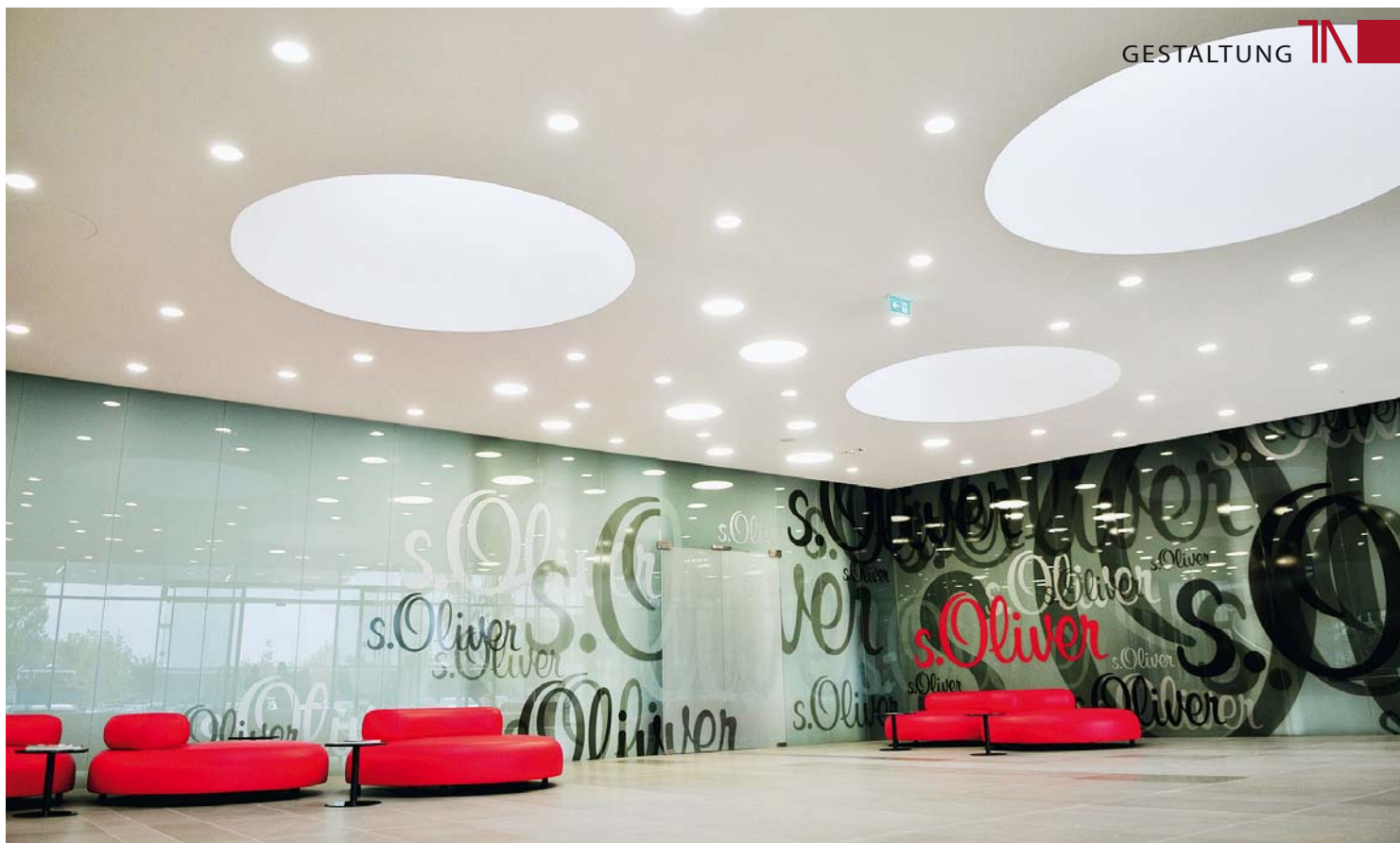
Eingangsbereich. Die große Deckenfläche ist aus mit Blähglas granulierten Paneelen (Sto-Verotec) fugenlos gebaut und mit einem hochfeinen Akustikputz beschichtet. Die Lichtkuppeln wurden von Jaeger Ausbau vor Ort eingepasst.
